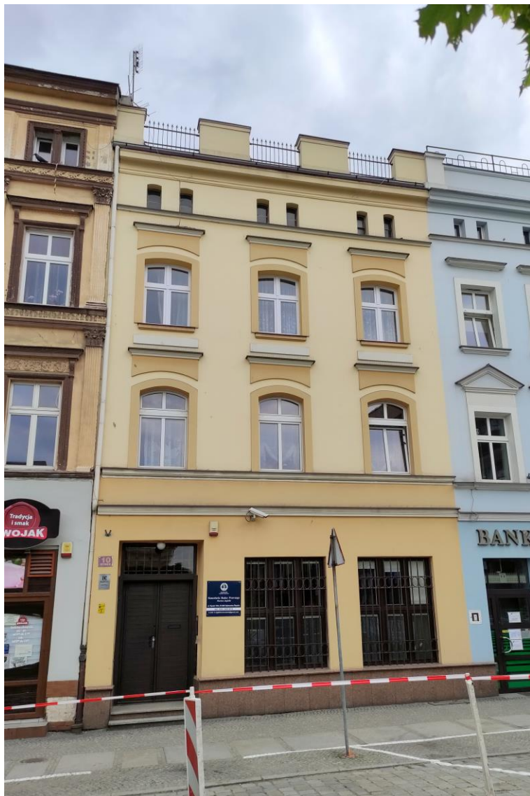
Widok budynku od południowego – wschodu.
