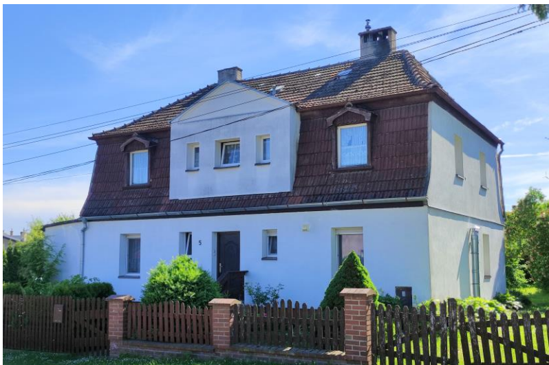
Widok budynku nr 5 od północnego – wschodu.
