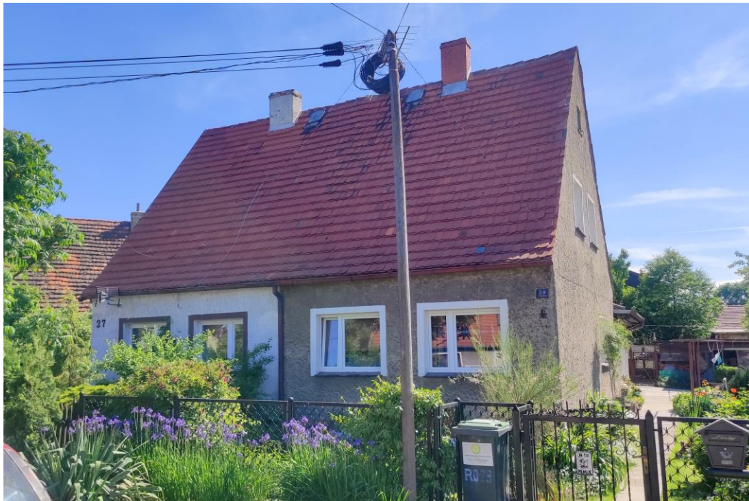
Widok budynku od północy.
