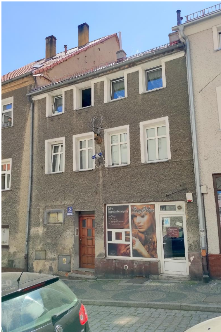
Widok budynku od północy.
