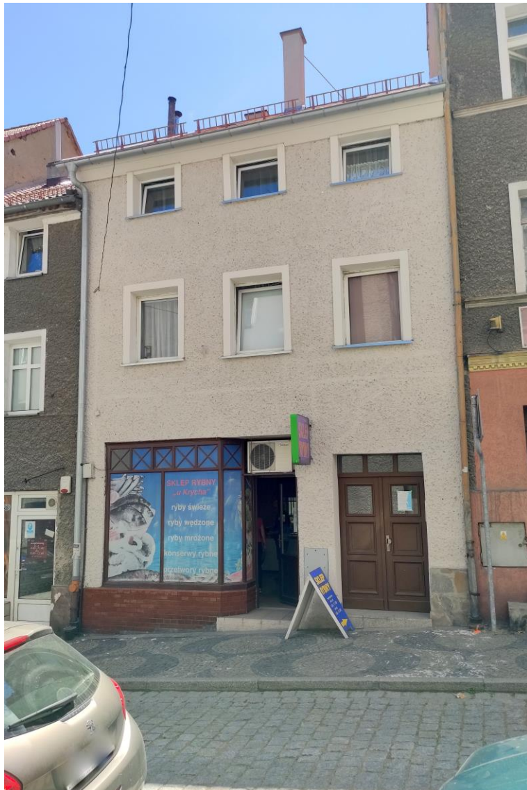
Widok budynku od północy
