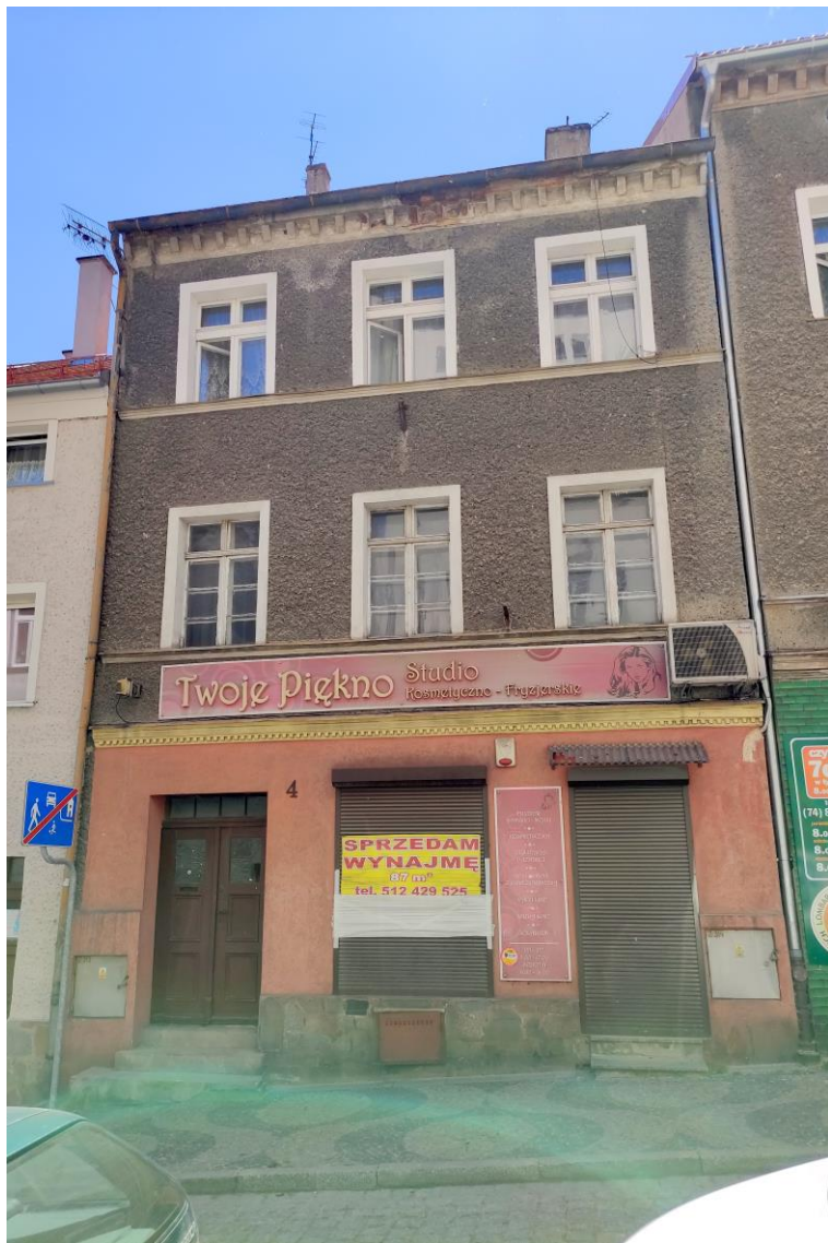
Widok budynku od północy.
