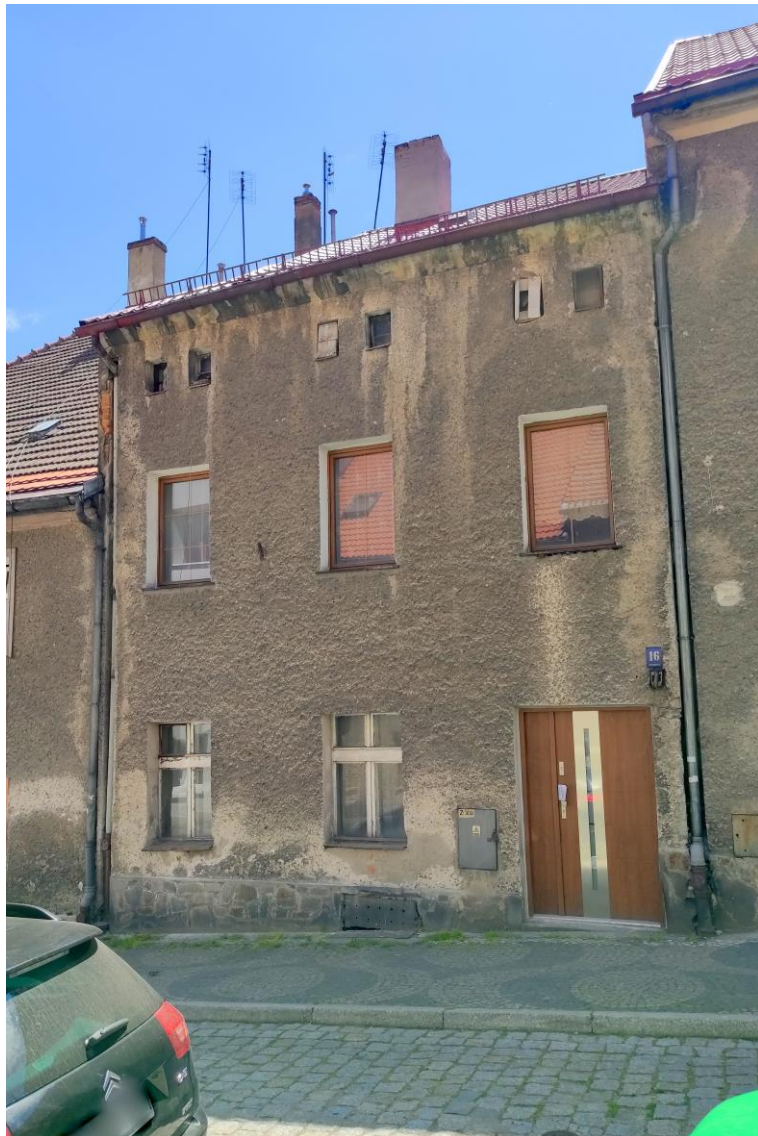
Widok budynku od północy.
