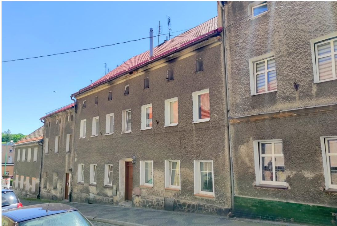
Widok budynku od północnego – zachodu.
