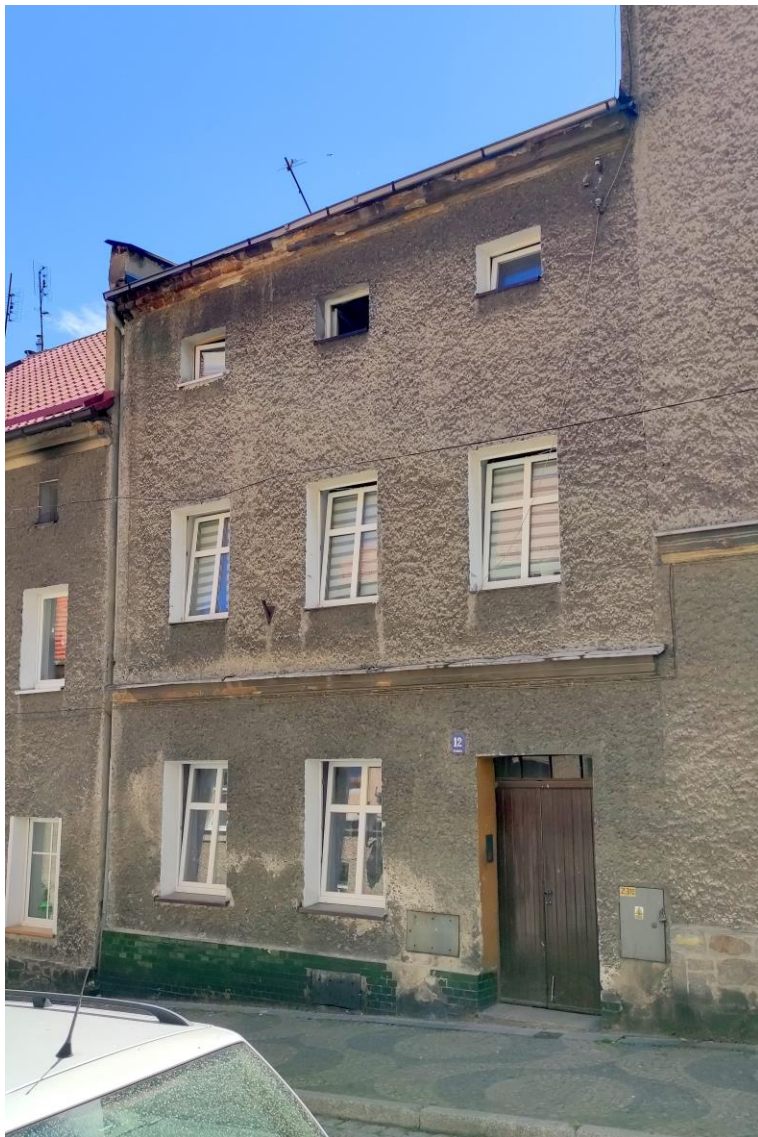
Widok budynku od północy.
