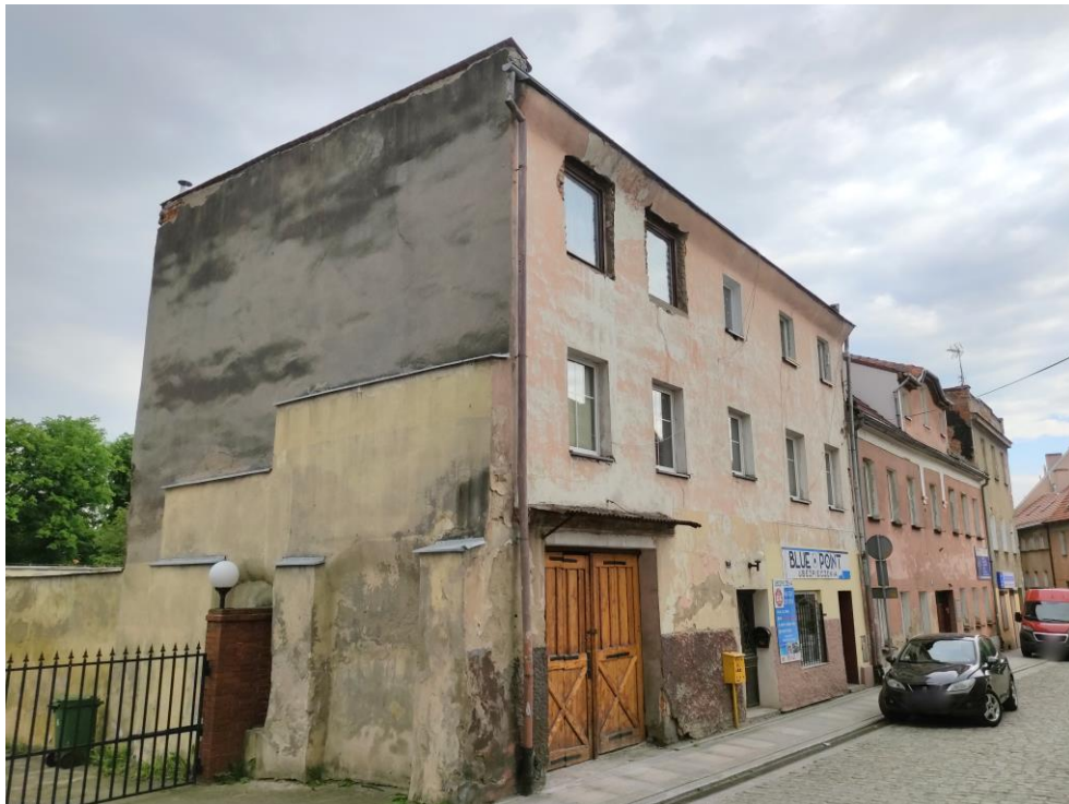
Widok budynku od północnego – zachodu.
