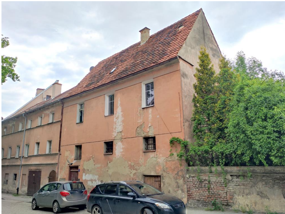
Widok budynku od północnego – wschodu.
