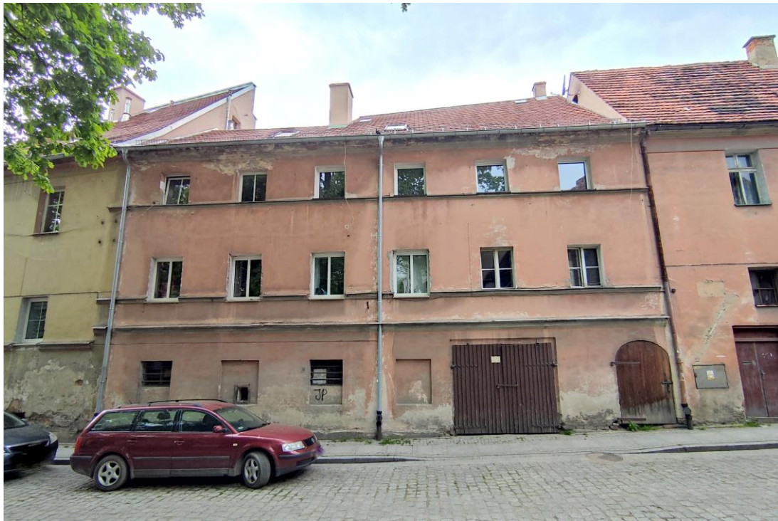
Widok budynku od północnego – wschodu.
