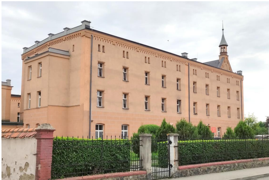
Widok budynku od północy.
