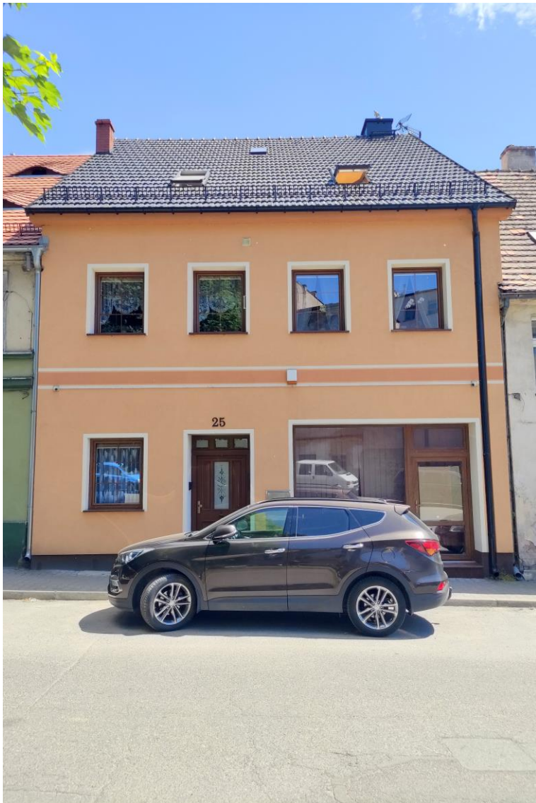
Widok budynku od północnego – zachodu.
