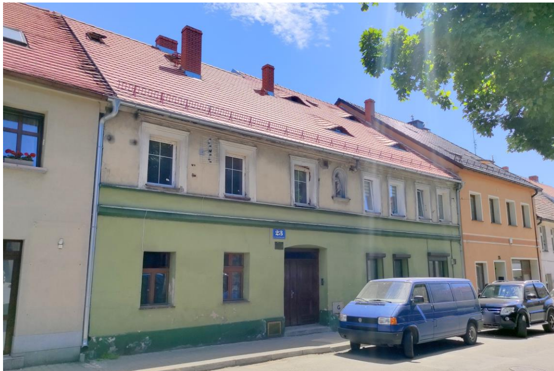
Widok budynku od północy.
