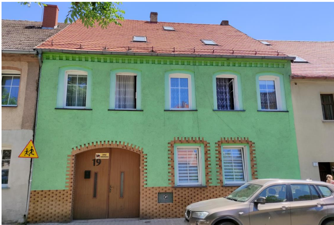
Widok budynku od północnego – zachodu.
