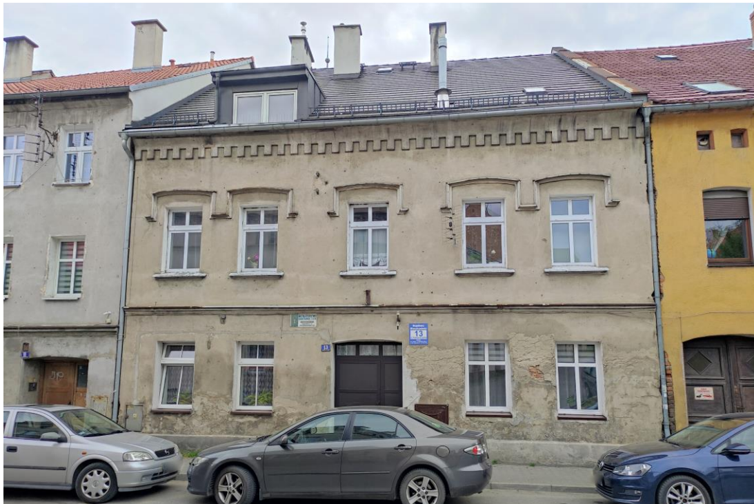
Widok budynku od północnego – zachodu.
