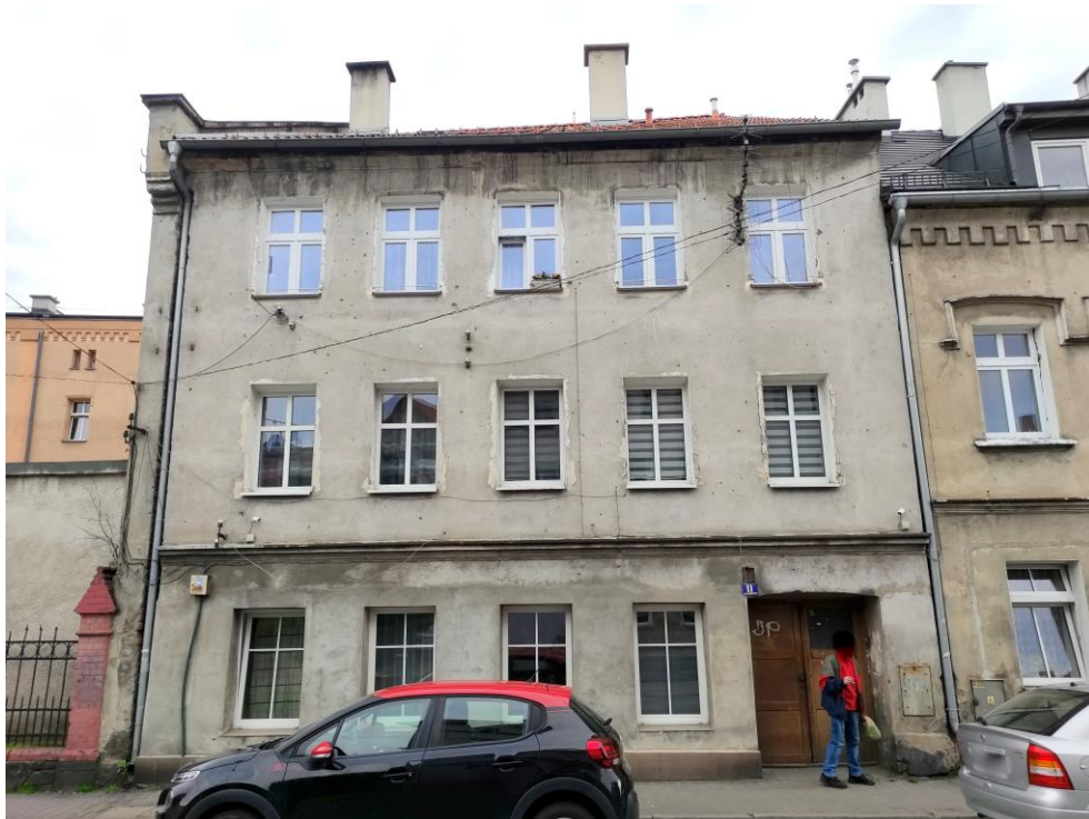
Widok budynku od północnego – zachodu.
