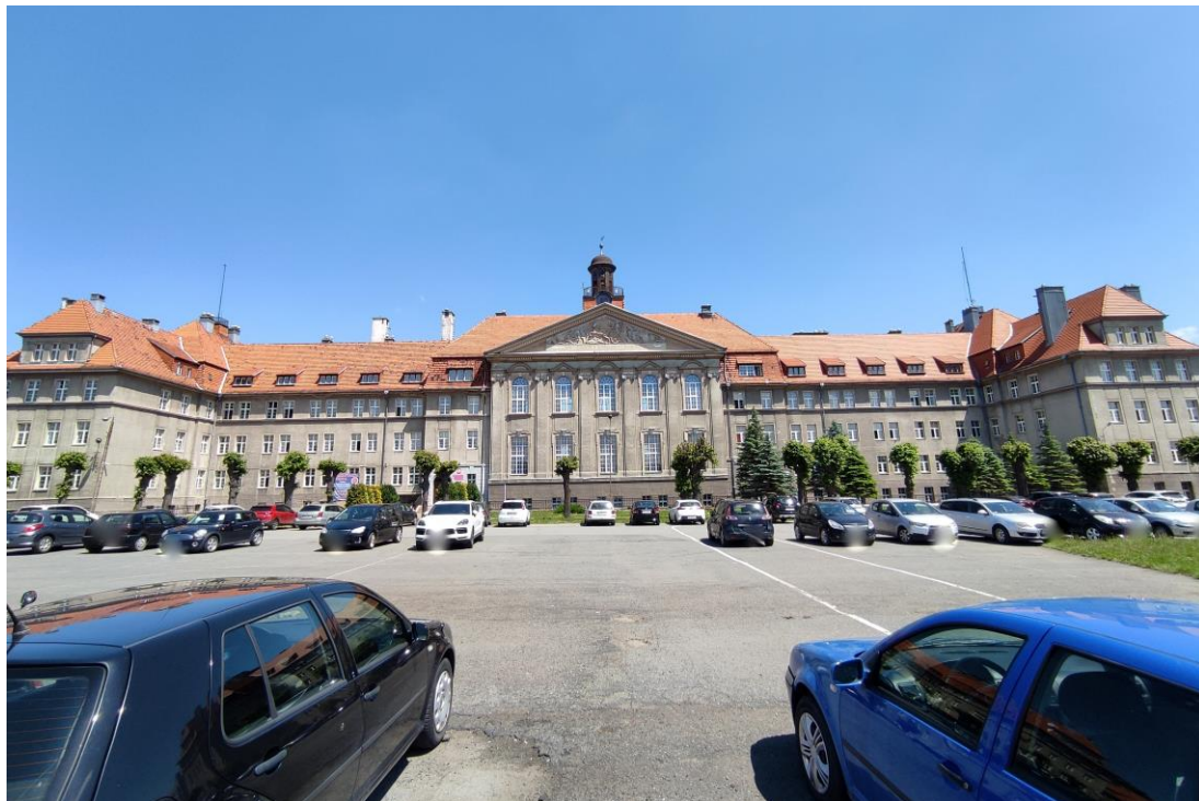
Widok budynku od południowego – wschodu.
