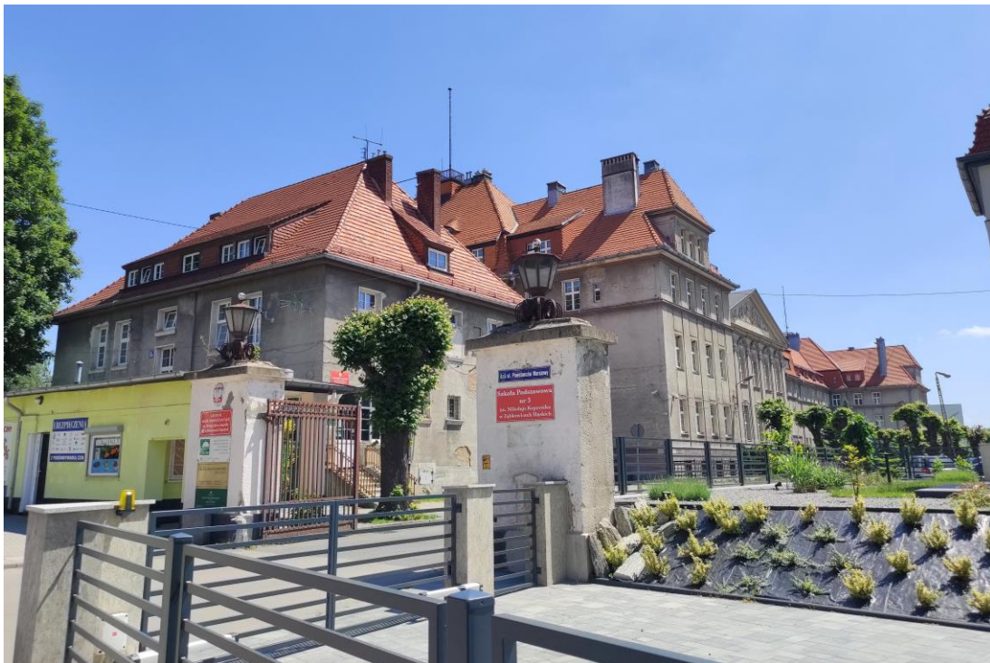
Widok od północnego – zachodu.
