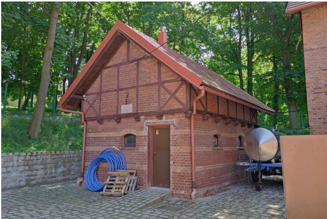
Widok budynku od północy.
