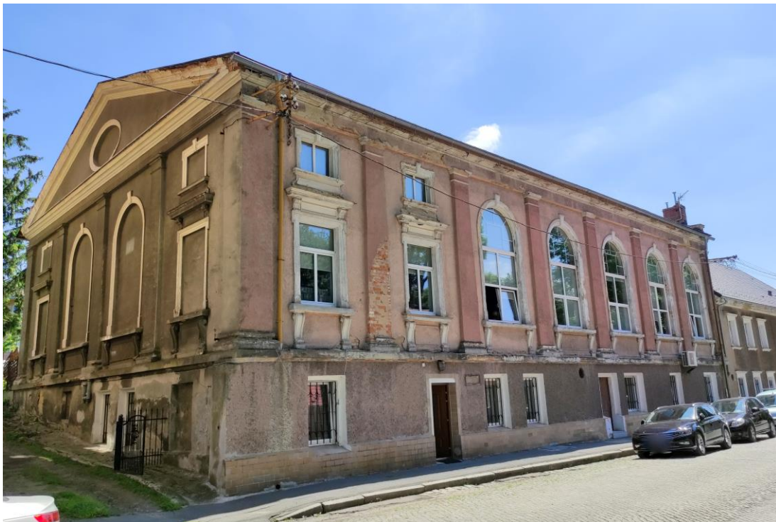
Widok budynku od północnego – zachodu.
