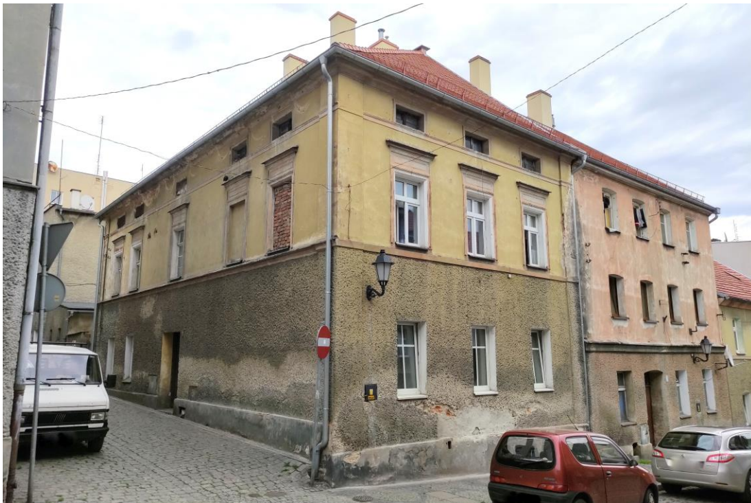
Widok budynku od południowego – zachodu.
