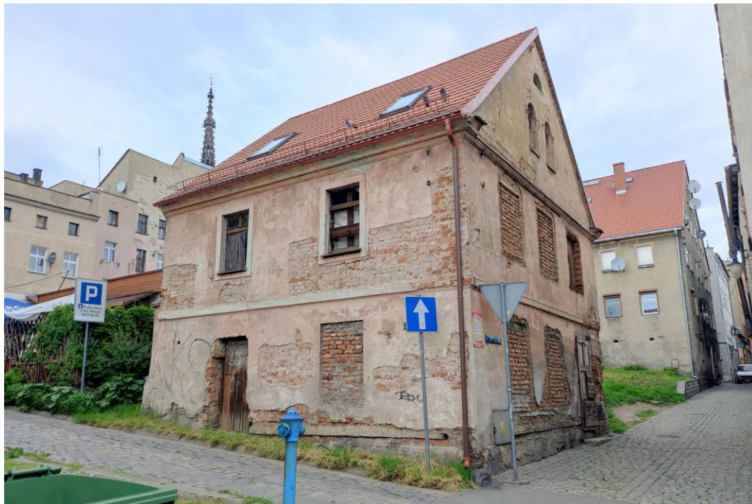
Widok budynku od południowego – wschodu.
