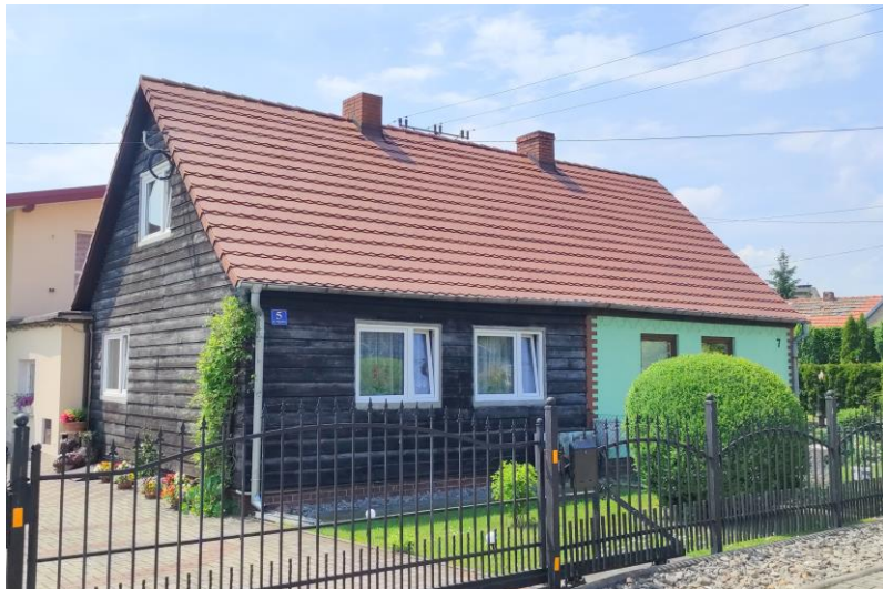
Widok budynku nr 5 od północnego - wschodu
