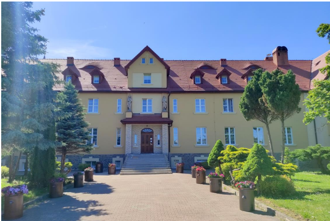
Widok budynku od wschodu.
