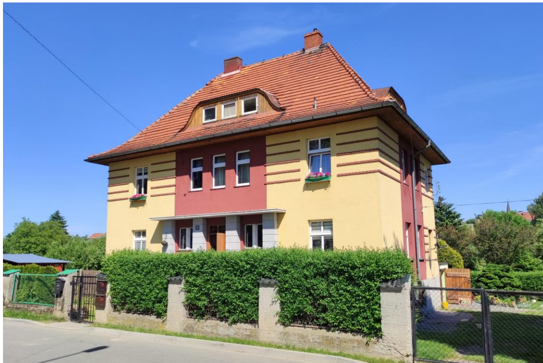
Widok budynku od południowego – zachodu.
