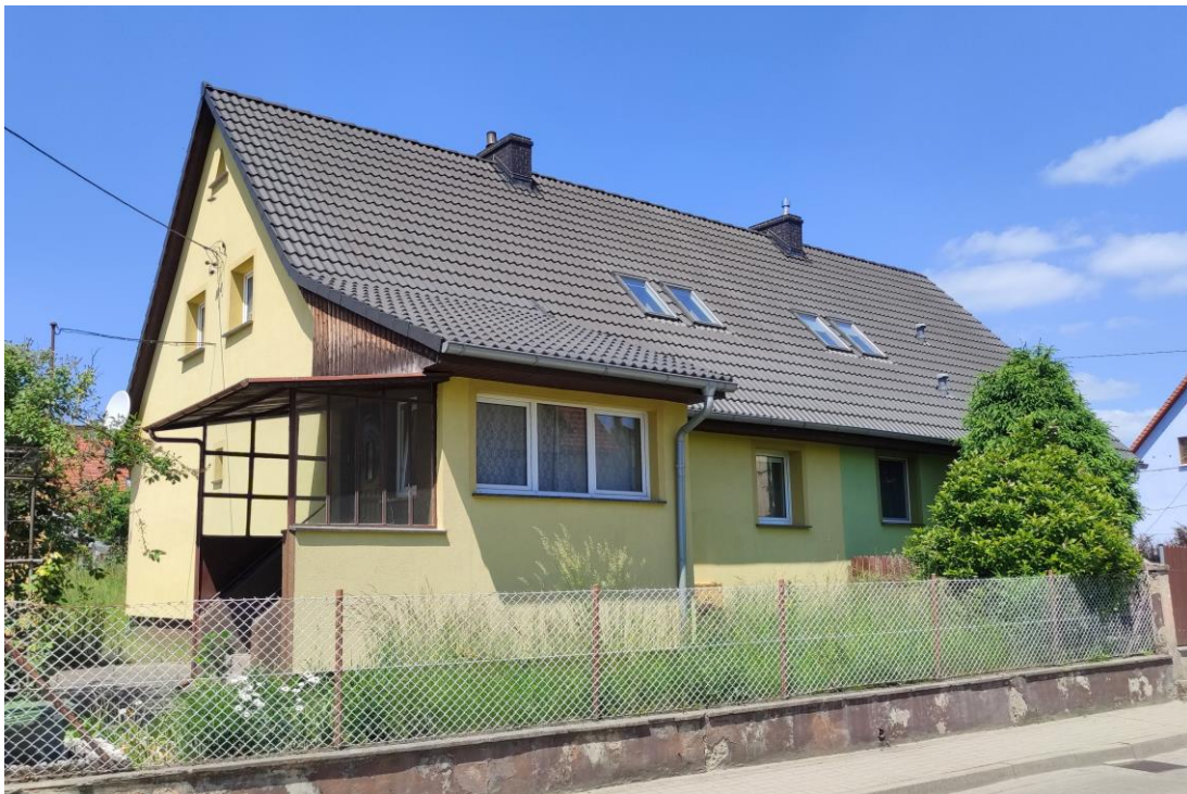
Widok budynku od południowego – wschodu.
