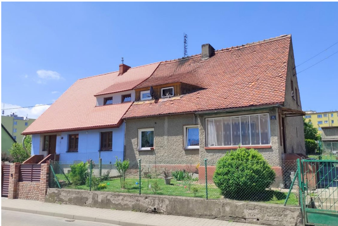
Widok budynku od północnego – wschodu.
