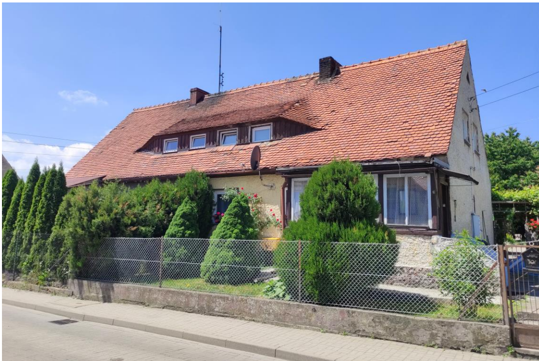
Widok budynku od północnego – wschodu.
