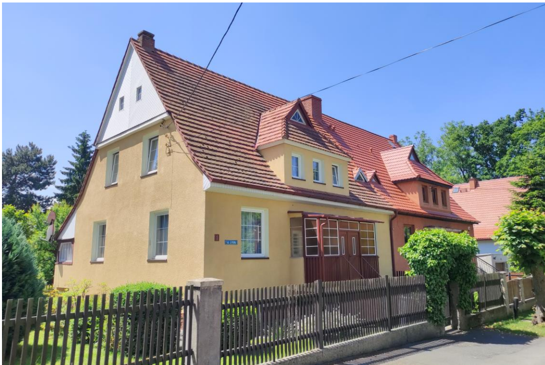
Widok budynku od wschodu.
