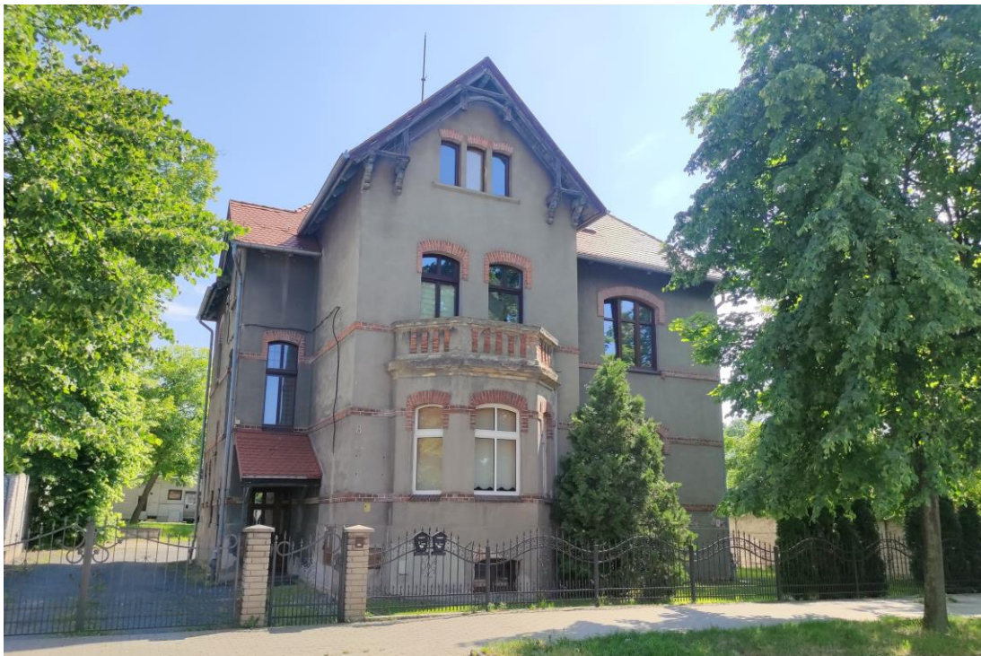
Widok budynku od południowego – zachodu.
