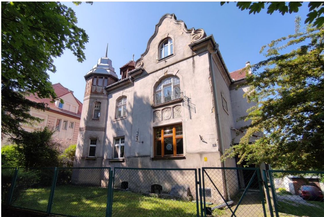
Widok budynku od północnego – wschodu.
