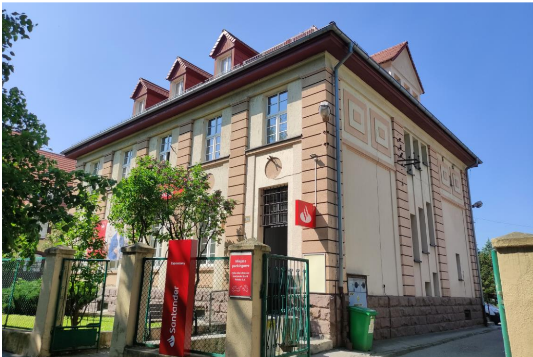
Widok budynku od północnego – wschodu.
