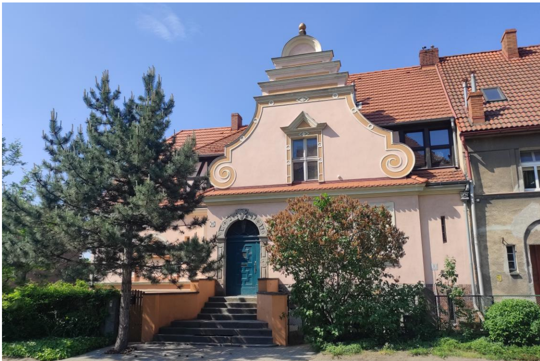
Widok budynku od północnego – wschodu.
