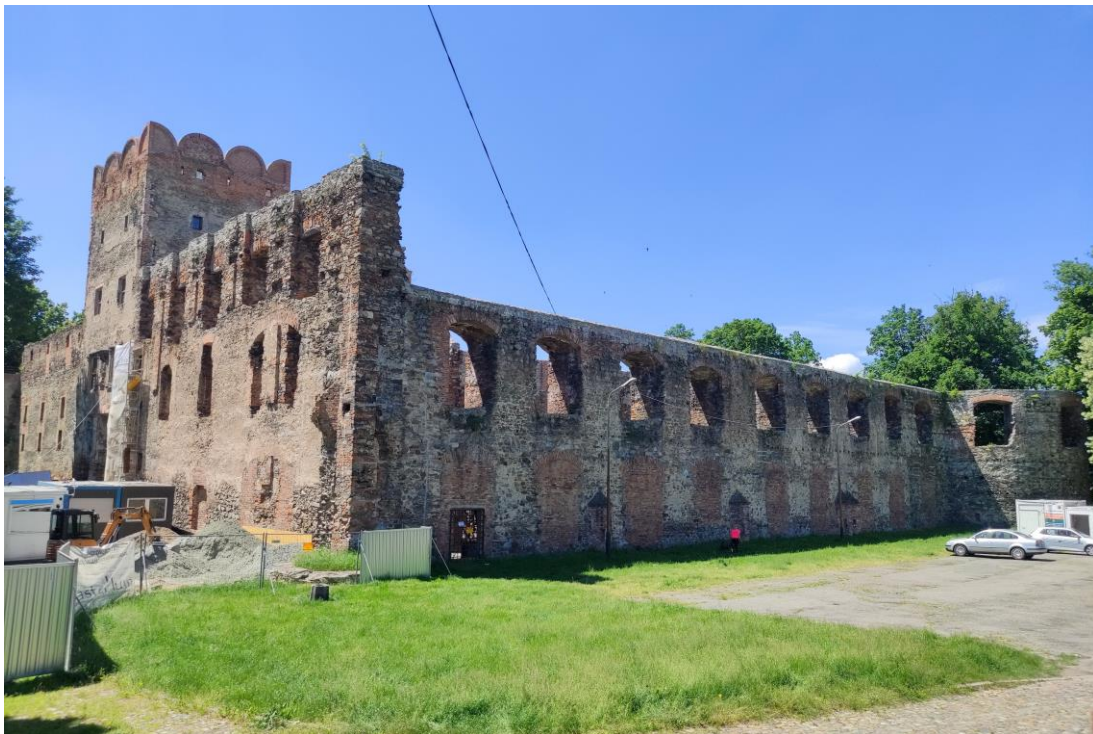
Widok budynku od północnego – wschodu.
