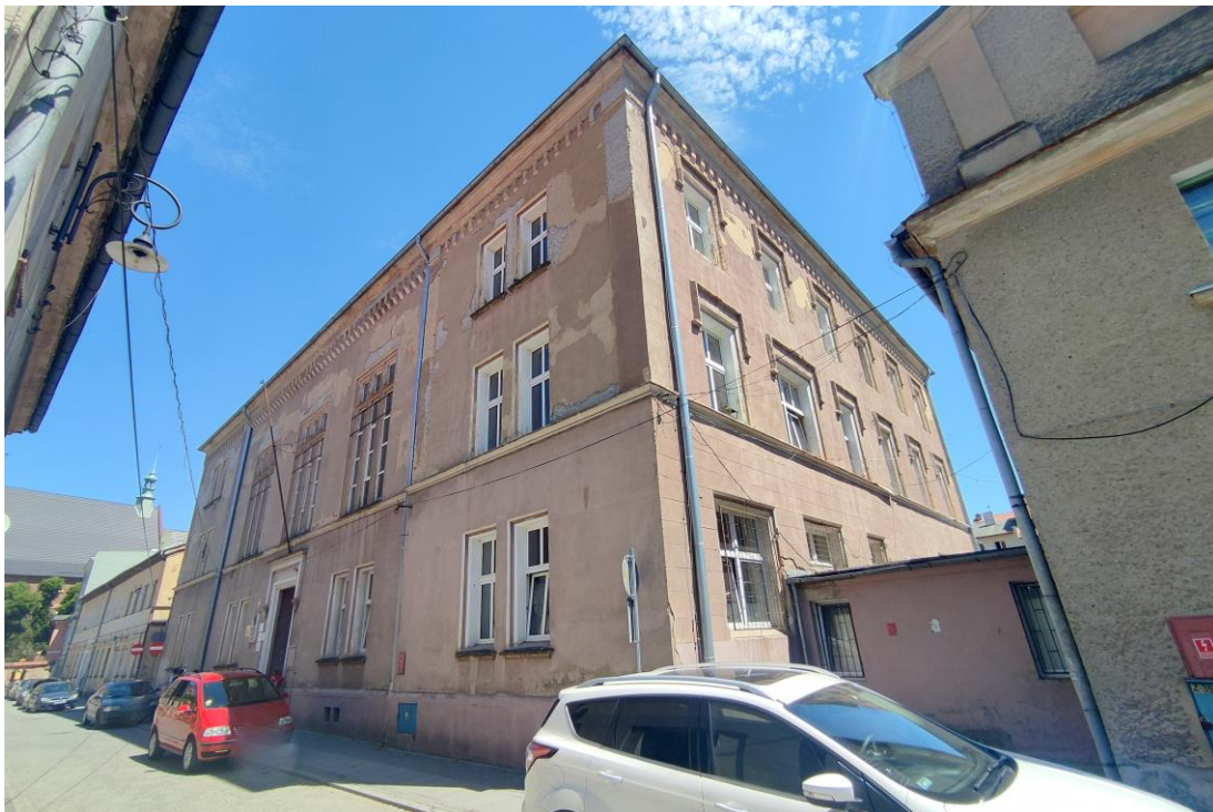
Widok budynku od południowego – zachodu.
