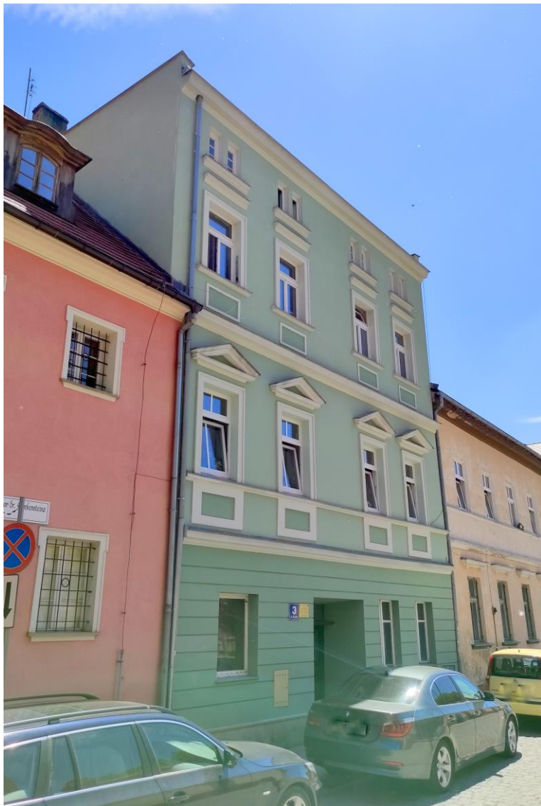
Widok budynku od północnego – zachodu.
