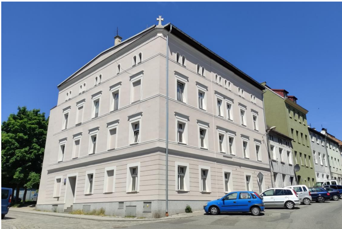
Widok budynku od południowego – wschodu.
