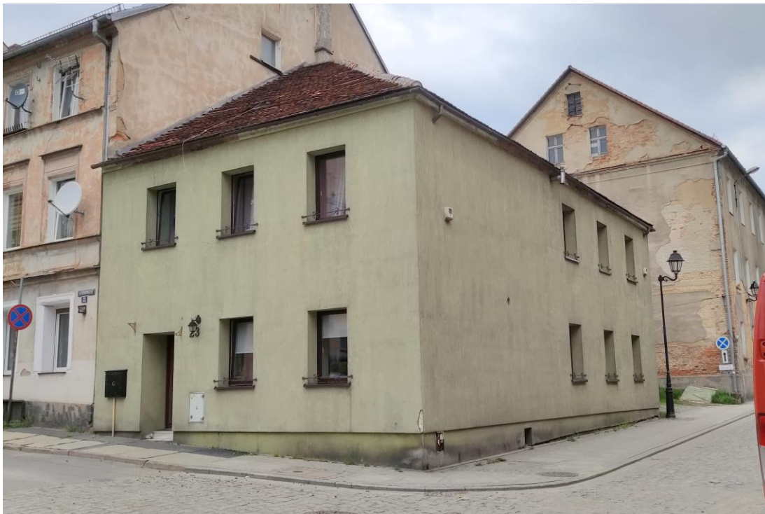
Widok budynku od południowego – wschodu.
