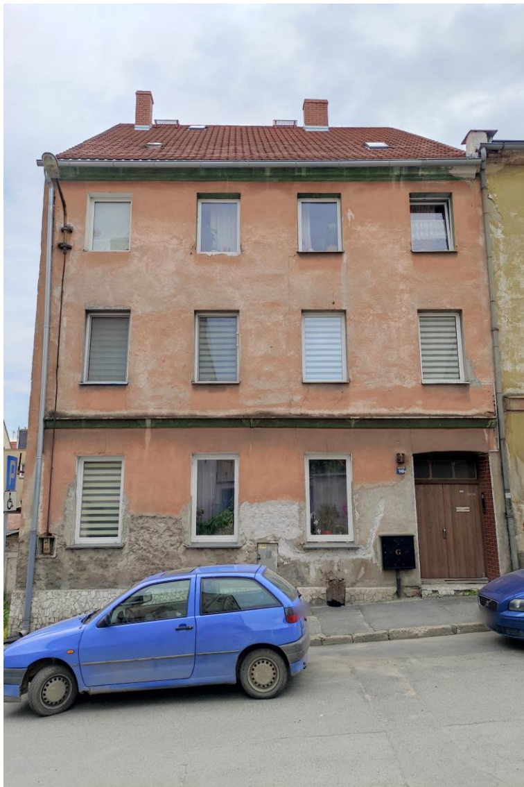
Widok budynku od północy.
