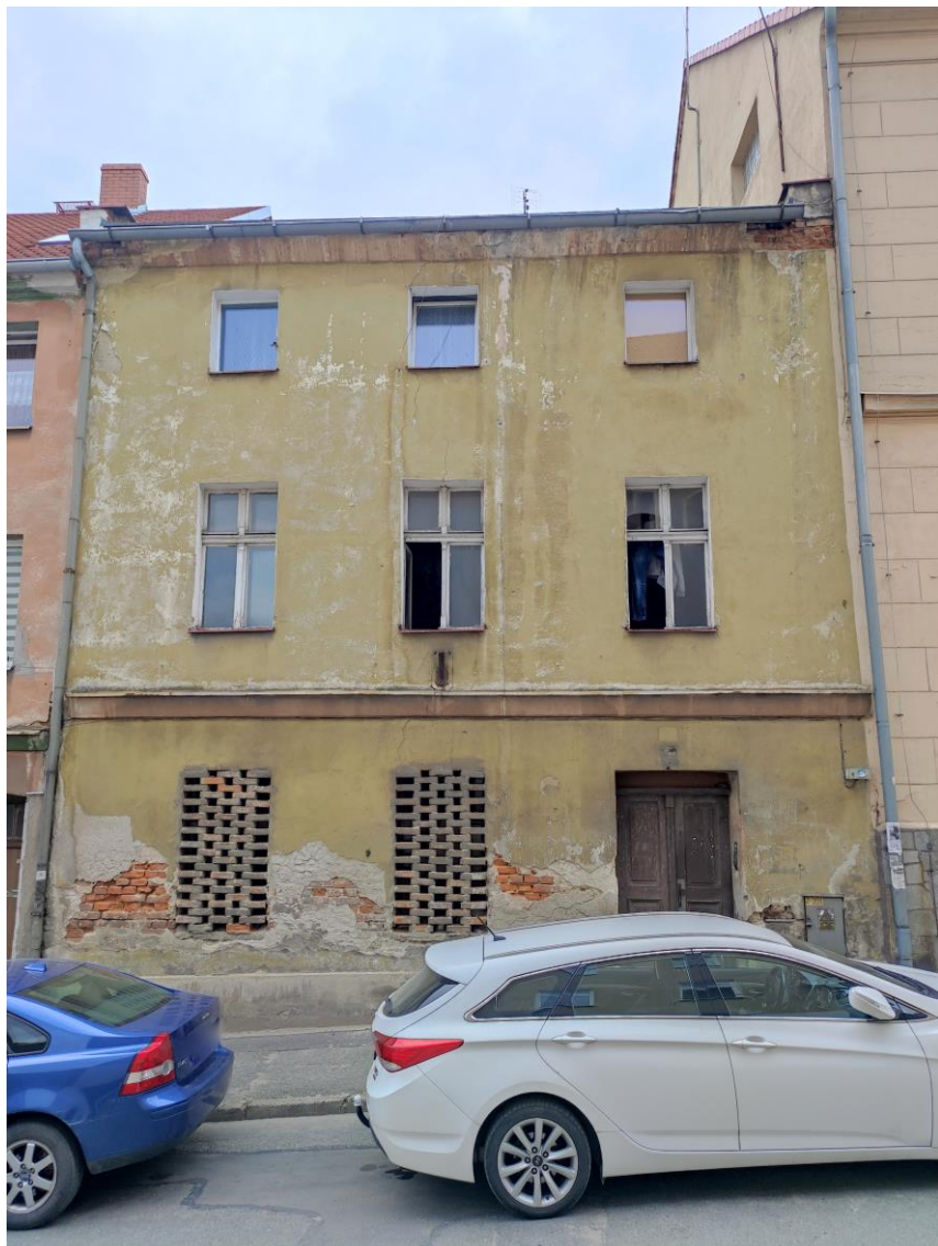
Widok budynku od północnego – wschodu.
