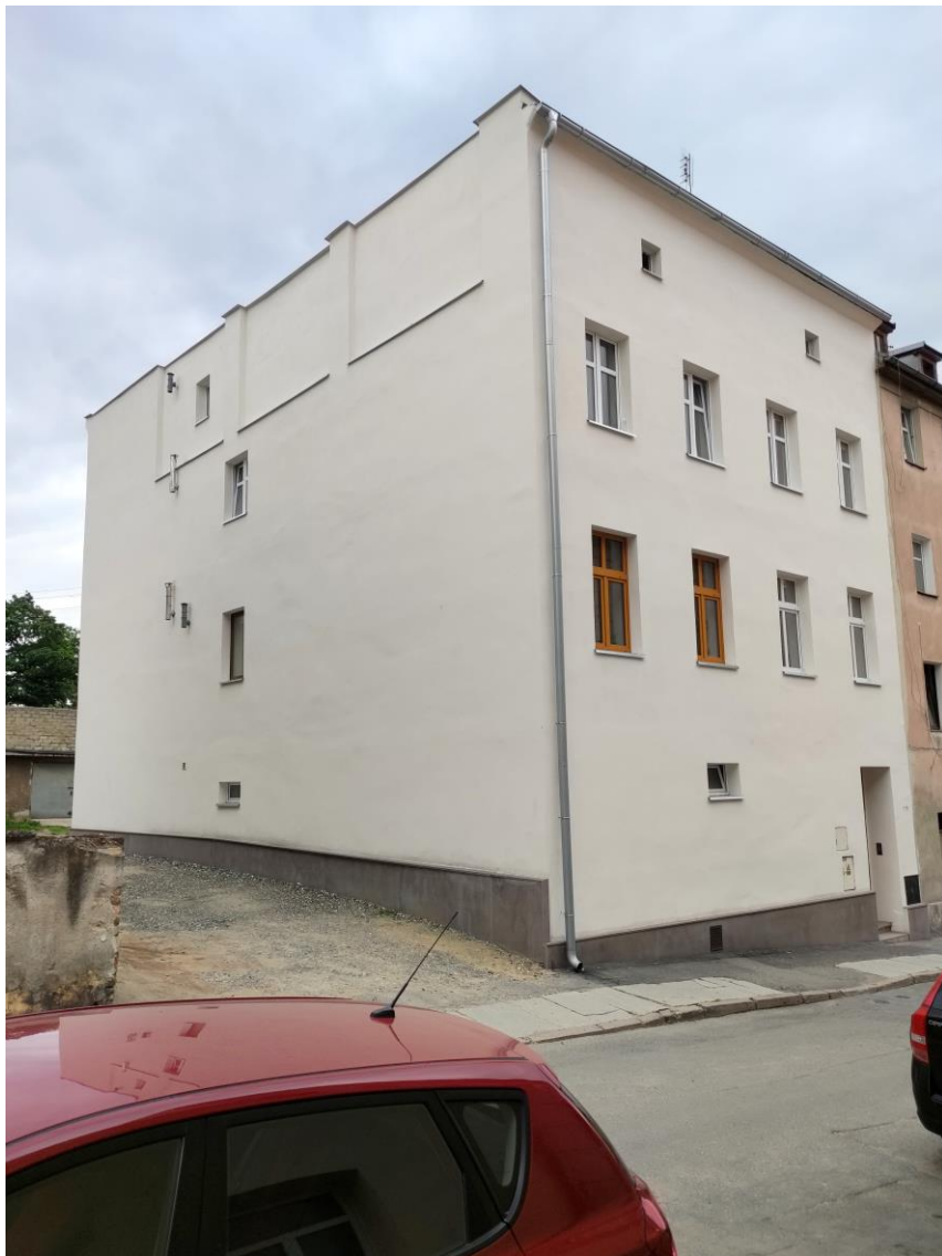
Widok budynku od południowego – zachodu.
