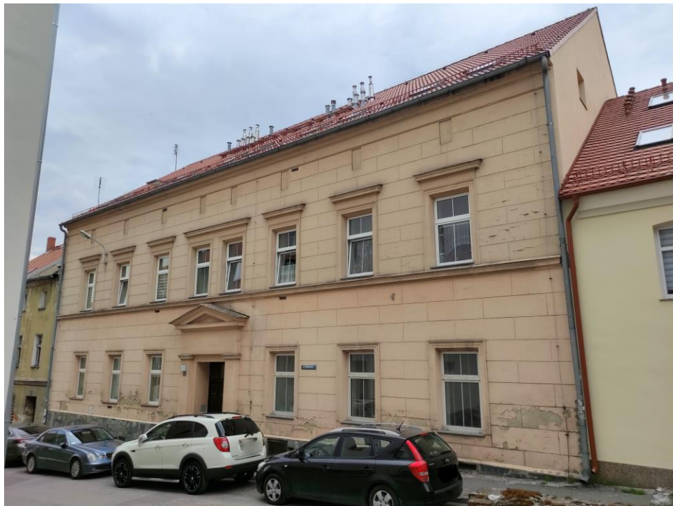
Widok budynku od północnego – zachodu.
