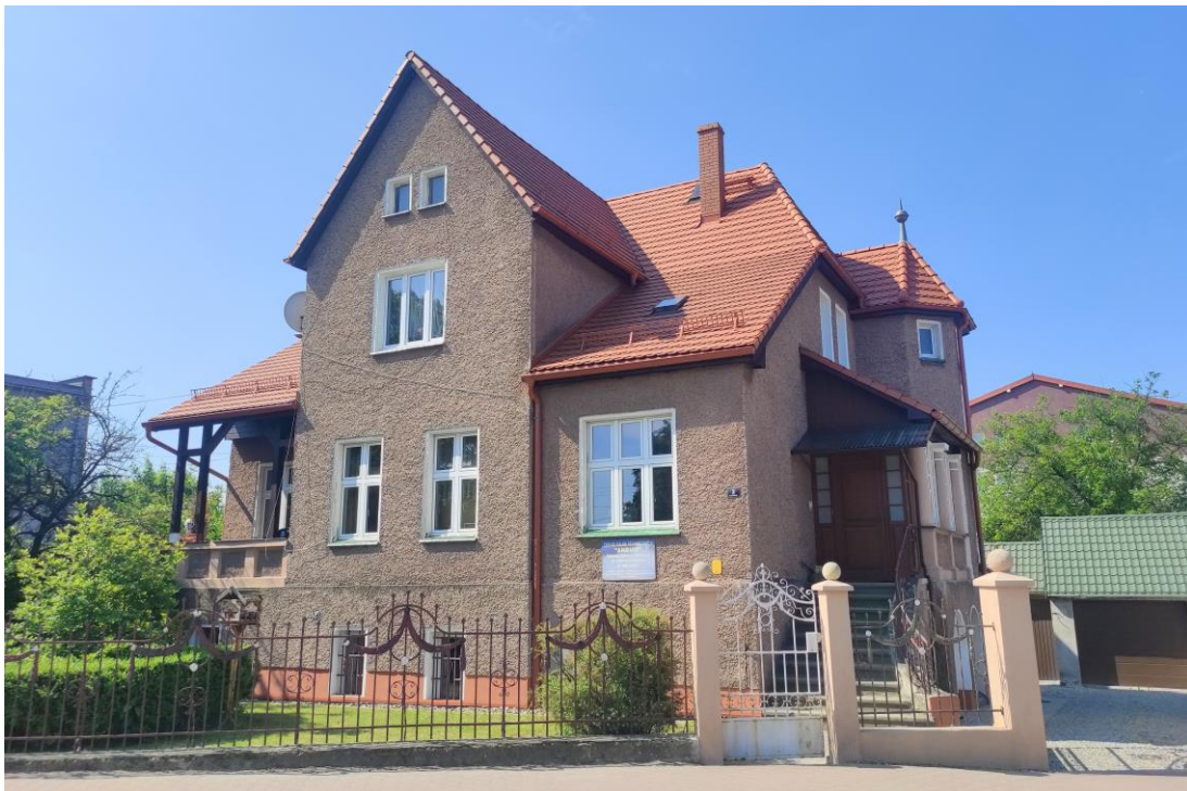
Widok budynku od północy.
