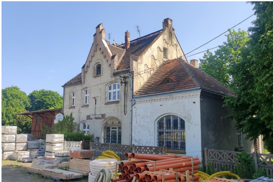
Widok budynku od południowego – zachodu.
