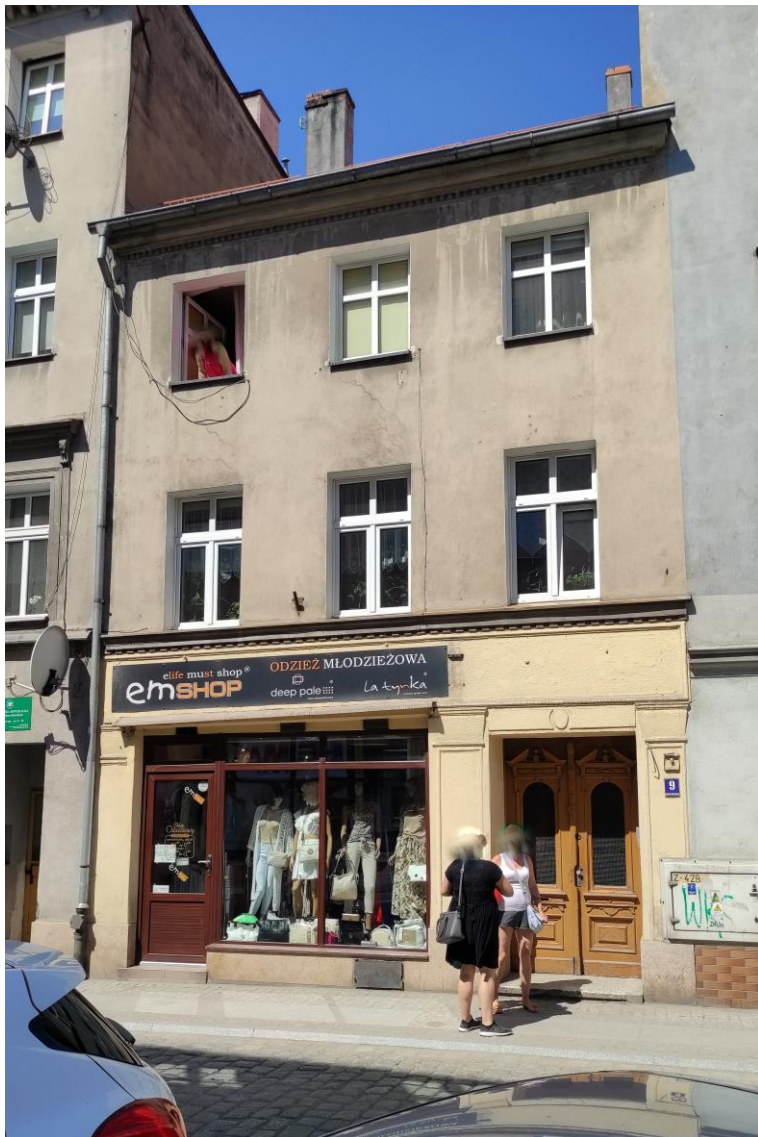
Widok budynku od wschodu.
