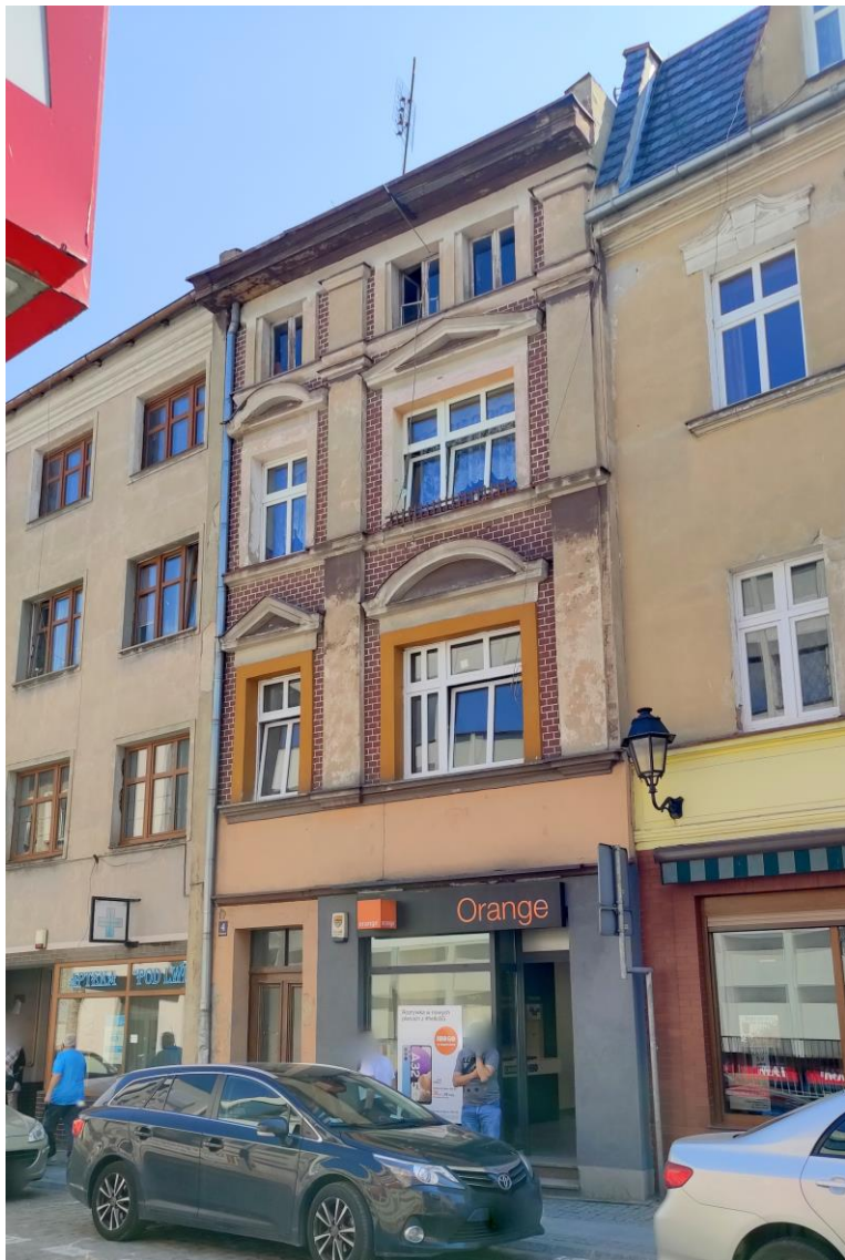
Widok budynku od południowego – zachodu.
