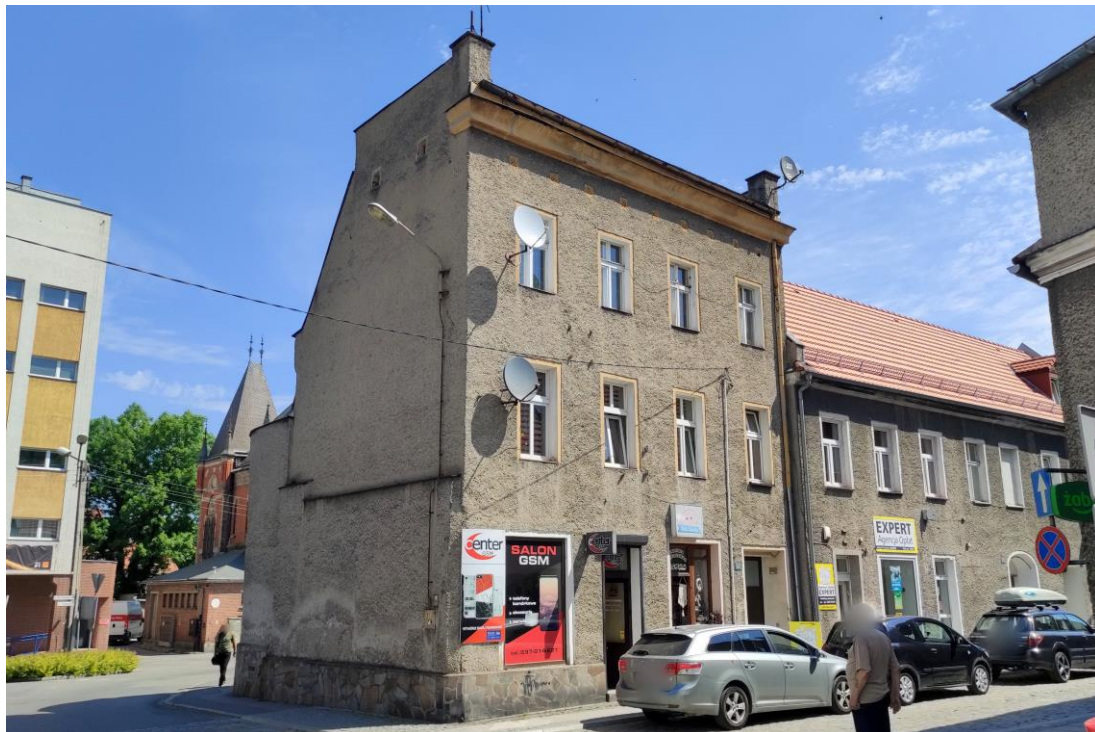
Widok budynku od południowego – zachodu.
