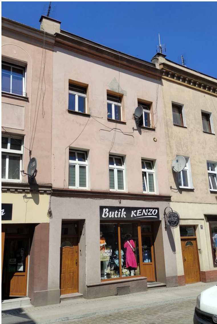
Widok budynku od południowego – wschodu.
